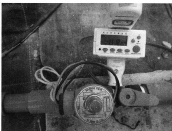
写真2. 電磁弁とウィークリータイマー
